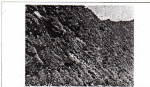
Figura 6: Empradizados, Taludes altos.
