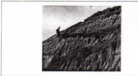
Figura 5: Cárcavamiento de Taludes de corte. 1990
